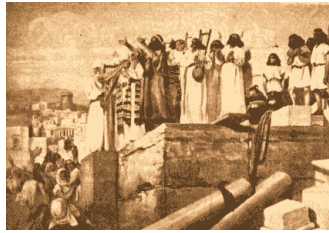
Строительство Второго Иерусалимского храма
